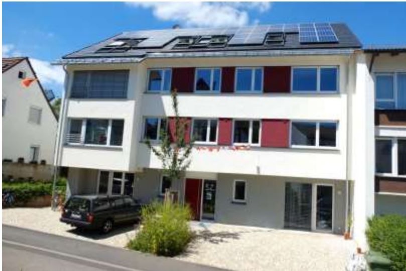
Wohnhaus mit Photovoltaikanlage in Stuttgart.
